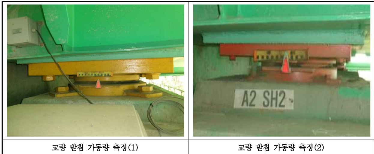
【사진 19.3.18】 교량받침 이동량 측정
