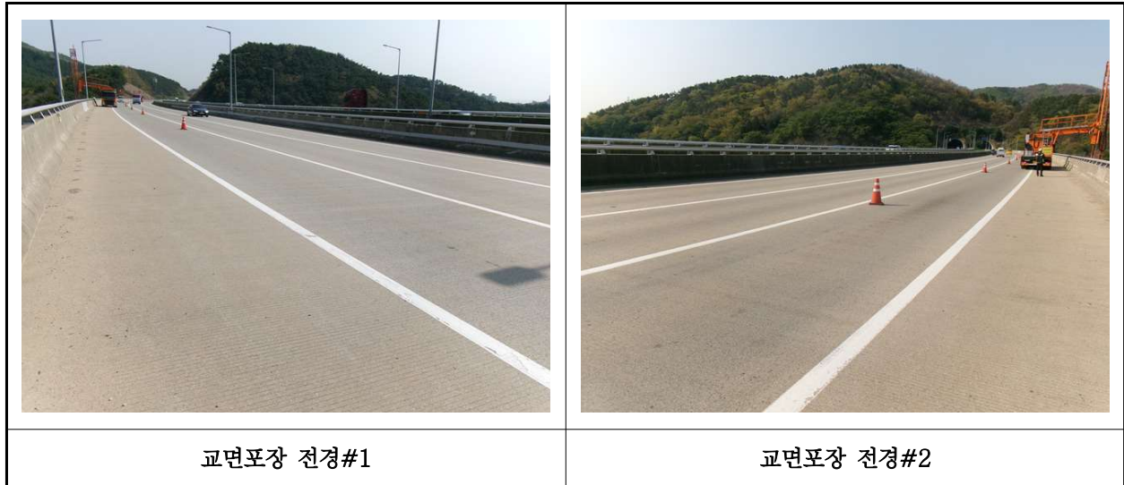
【사진 19.3.22】 교면포장 전경
