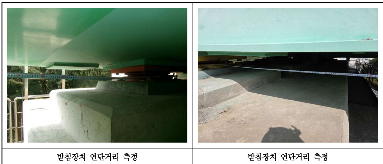
【사진 19.3.17】 교량받침장치 연단거리측정
