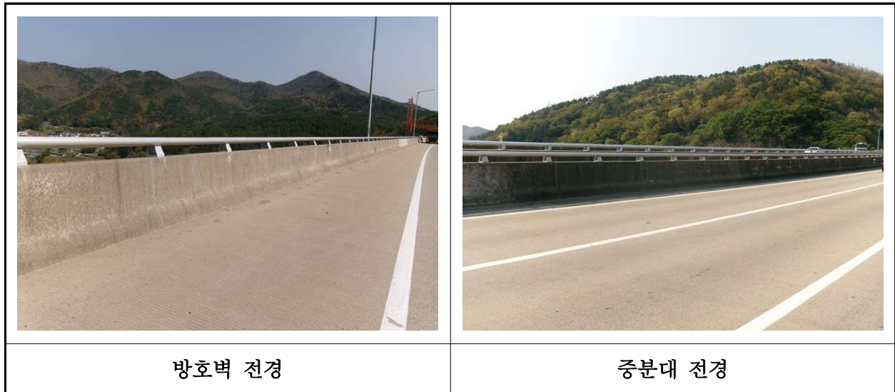
【사진 19.3.26】 방호벽 및 중분대 전경
