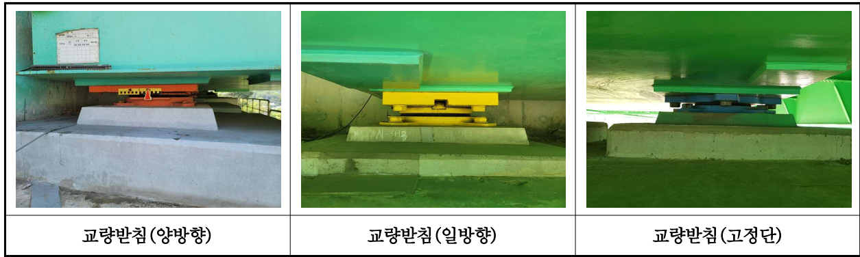
【사진 19.3.15】 교량받침 전경
