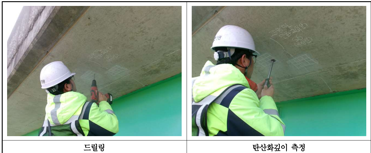
【사진 19.4.3】 탄산화 깊이 측정 현장사진
