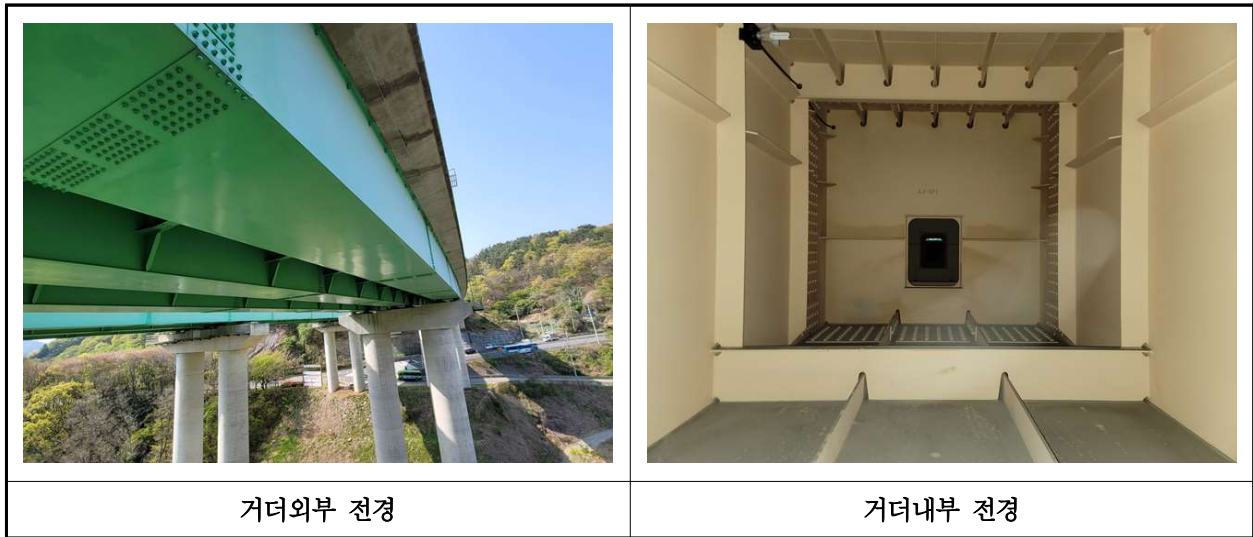
【사진 19.3.4】 거더 전경
