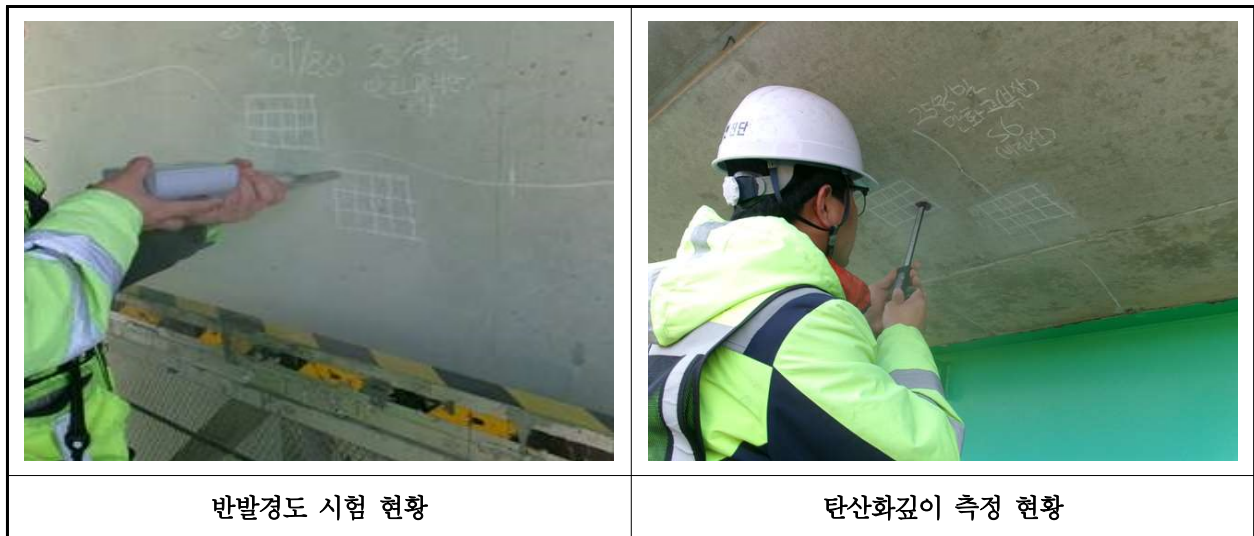
【사진 19.4.1】 콘크리트 내구성조사 현황
