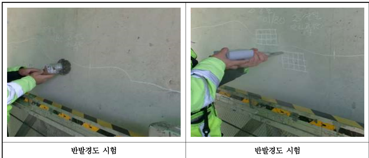
【사진 19.4.2】 반발경도시험 현장사진
